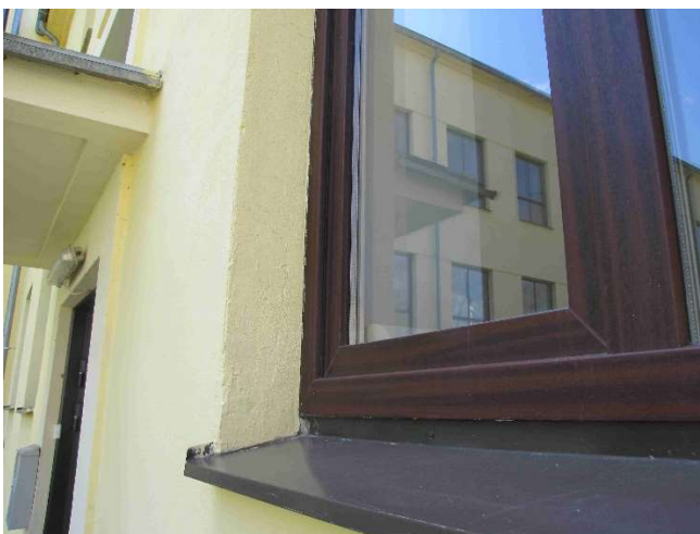
Joonis 12. Tüüpiline 2xklaaspaketiga aken
